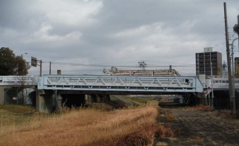
④浜中津橋 阪神間鉄道施設の際にイギリスから輸入、旧中津川に架けられた橋梁を道路橋に転用。鉄道用トラス桁の転用例。
