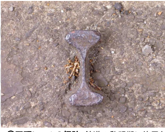
①双頭レールの輪跡 鉄道の黎明期に使用された双頭レールを橋に転用した例。
