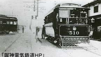
②阪神北大阪線跡 野田-天六4.3kmを結んでいた。大正3年開業、昭和50年廃止。かつて真面有馬電気軌道と北野で平面交差となっていた。
