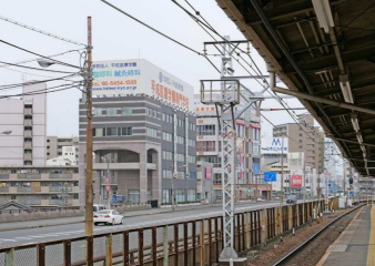
③大阪市営トロリーバス架線柱1号線:大阪駅前-神崎橋間5.7km跡で、中津浜~十三間で架線柱が多く残されている。昭和44年廃止。
