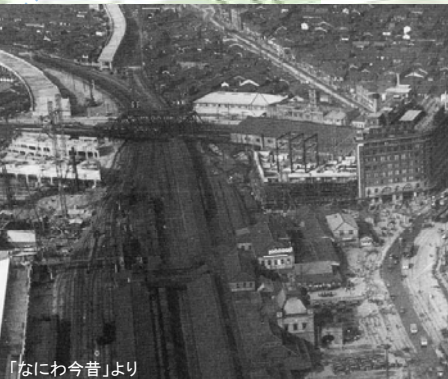
⑰省線高架阪急地上化工事 昭和9年に省線東海道本線、城東線が高架となり、それまで高架で省線を乗り越えていた阪急電鉄は地平面化され、5月31日に切り替え工事が行われた。また、この頃、城東線旧線跡の払い下げを受けた京阪が桜ノ宮から梅田に乗り入れる計画があった。昭和48年、阪急梅田駅は国鉄線北側へ転移高架化拡張工事が行われた。
