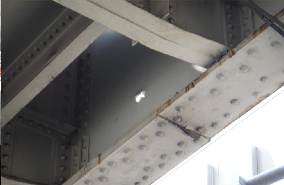
柱脚や橋桁には、昭和20年 大阪空襲による機銃射撃の跡が残されている。
