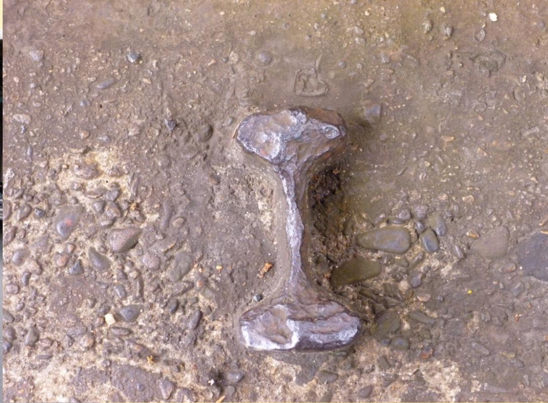
阪急中津駅前に残る、官営鉄道黎明期に使われた「**双頭レール**」の柵跡。双頭レールはイギリスで考案、上下を同じ形状に製造し、頭部が摩耗したら反転させて底部を使用した。当時は、鉄が貴重品であった。
