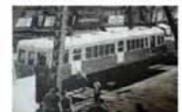
大阪地下鉄車両搬入場所 本町・南御堂前
